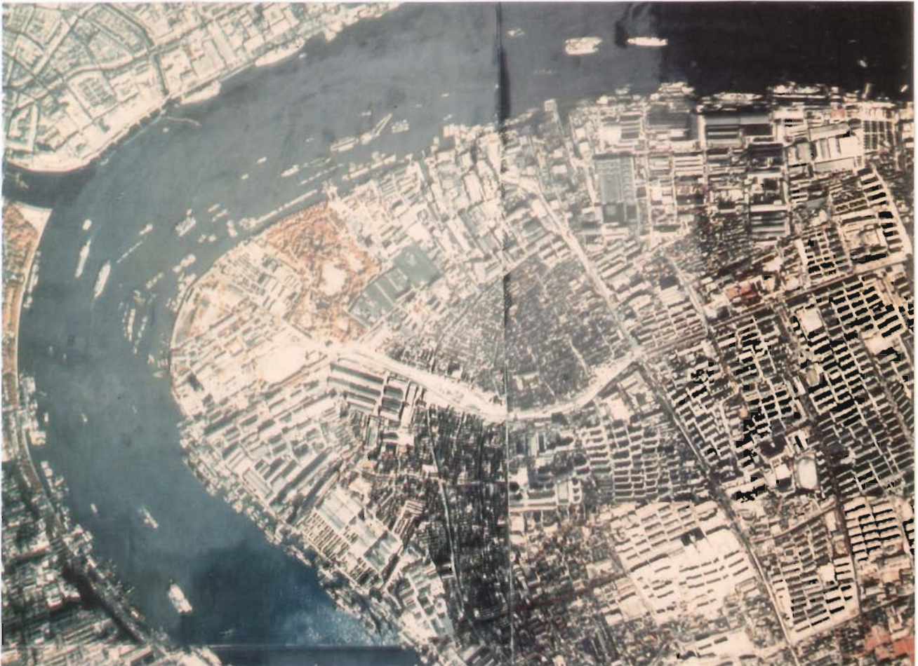
Vue aérienne du site de Lu Jia Zui
